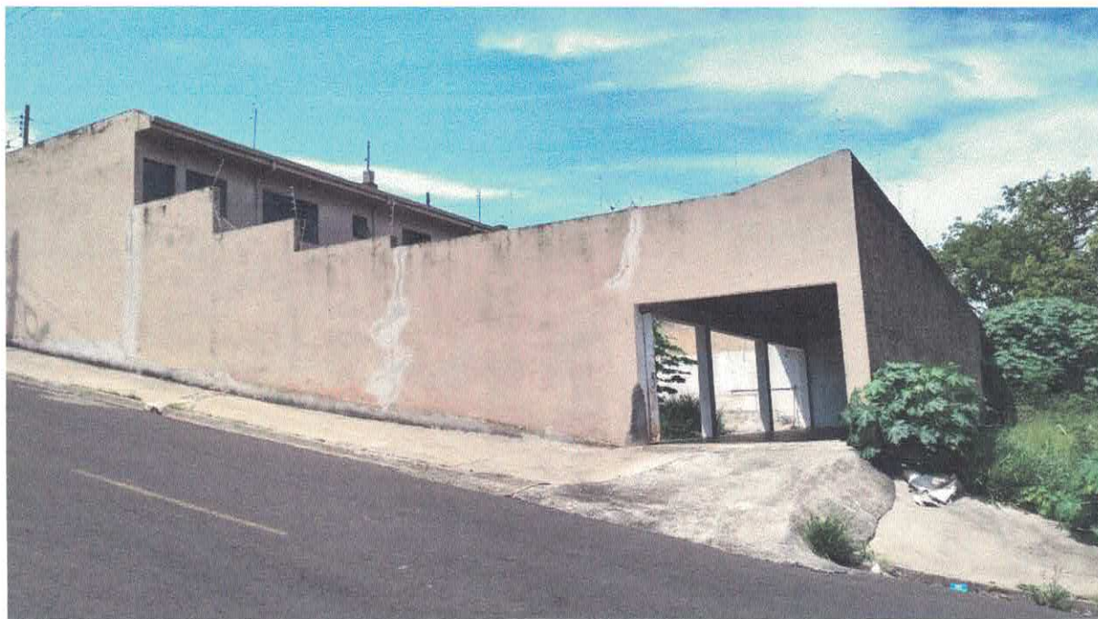
Figura 1 - Calçada na Rua Wenceslau Braz
