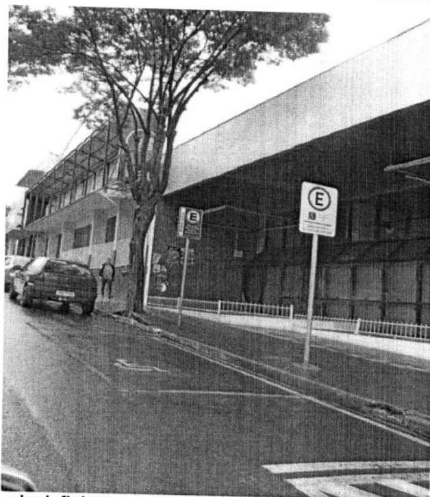
Figura 37: Vaga de deficiente com rampa inexistente – Banco Itaú – Área Central FONTE: GASINI
