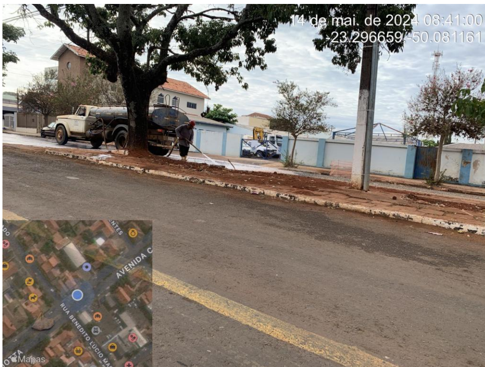
Foto 01 – Empresa responsável pela obra realizando a lavagem com auxílio de caminhão pipa
